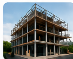
งานโครงสร้างน้ำหนักเบา
